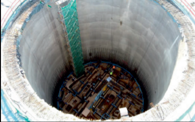
Betonnage Bodenplatte
