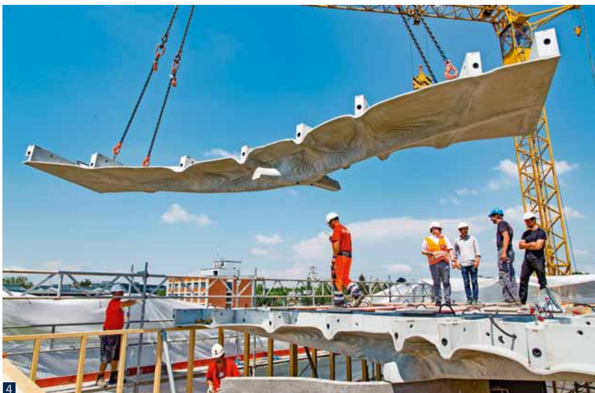
3 Roboter fertigen das Fassadengerüst des DFAB HOUSE. (Foto: Roman Keller)
