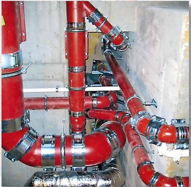
Die Aufprallzonen in Abflussleitungen sind kritische Bereiche für den Schallschutz. (Bild: Düker)
