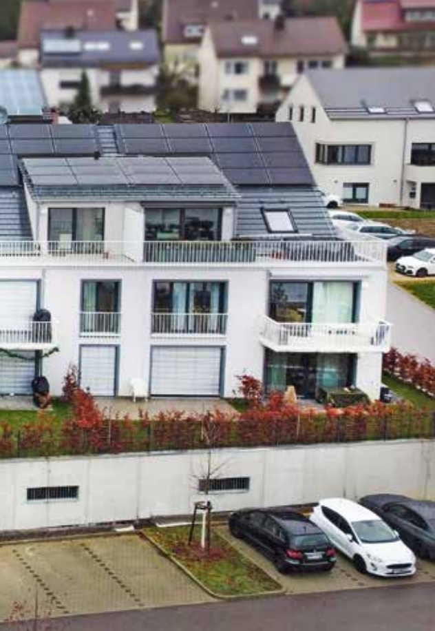
1 Die drei Mehrfamilienhäuser in Altbach bei Stuttgart werden jeweils über eine PVT-Wärmepumpen-Anlage mit Wärme versorgt. (Foto: Metzger GmbH & Co. KG)
